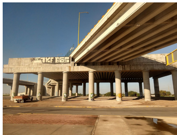
Figura 2. Inmediaciones del acceso a San Juan de Abajo. Fuente: Archivo propio. Visita de campo, 2 de julio de 2019.
