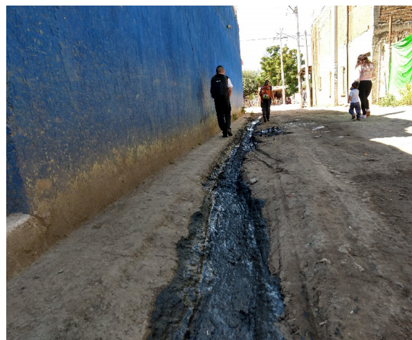
Figura 3. Drenajes improvisados en San Juan de Abajo. Fuente: Archivo propio. Visita de campo 5 de julio de 2019.
