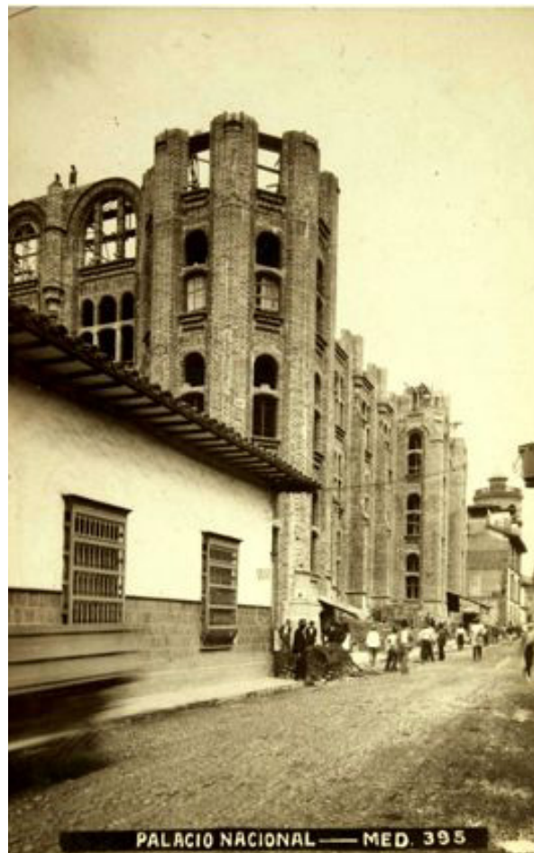
Figura 7. El Palacio Nacional en construcción, Medellín, fines de la década de 1920. La obra del belga Goovaerts expresa el deseo de modernidad del pueblo antioqueño y del gobierno de Pedro Nel Ospina. Fuente: Gonzalo Escobar, en https://www.centrodemedellin.co/ArticulosView.aspx?id=200
