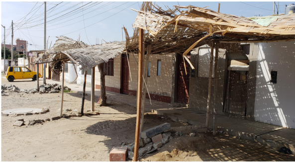
Figura 7. Distrito costeño de Nuevo Chimbote. Proceso de modernización informal. Las viviendas de adobe van dando paso a la estructura de ladrillo, los antiguos espacios semitechados de caña en algunos casos se conservan con esteras y en otros se van reemplazando con cemento para el uso del automóvil invadiendo el área pública. Fuente: Fotografía del autor, 2019.
