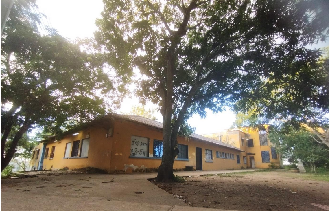
Figura 1. Fachada sur edificio de dormitorios de la ENS de Sincelejo.
