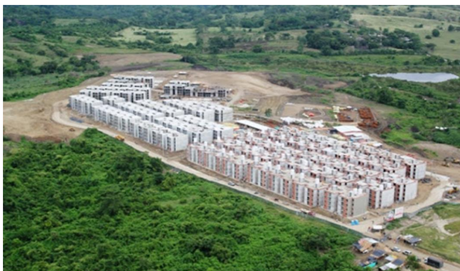
Figura 3. Conjunto de edificios de vivienda de interés social ubicadas en el barrio Altos de la Sabana, Sincelejo, Sucre.
