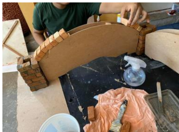
Figuras 20, 21 y 22. Desarrollo de arcos guías que soportara a cubierta tabicada de arista. Fuente: Morales (2021)
