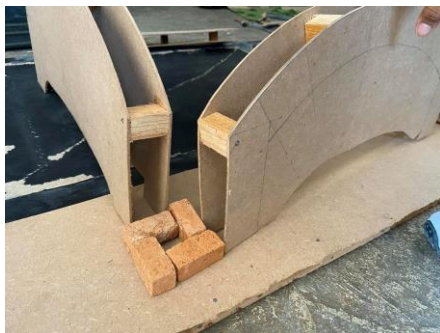
Figuras 18 y 19. Guías de triplay para el arranque de la cubierta y soporte de columna cuatropeada de tabique. Fuente: Morales (2021).
