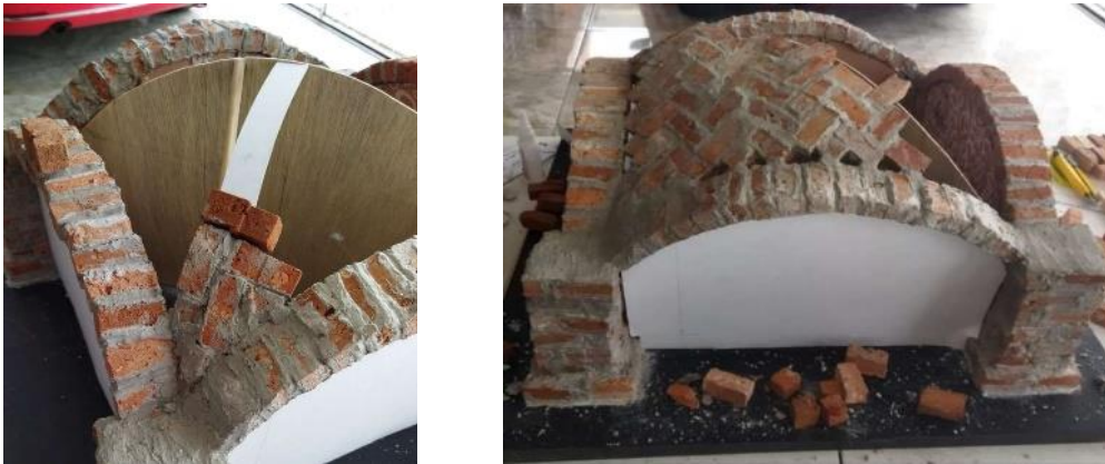
Figuras 35 y 36. Proceso de pegado de hiladas y terminación de la cubierta. Fuente: Morales (2021)
