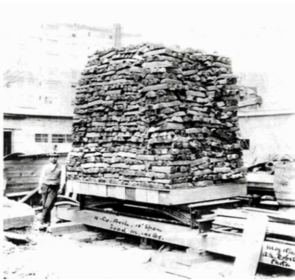
Figura 1. Prueba de Carga de Rafael Guastavino para la construcción de la Boston Public Library. Fuente: Lopez, 2012.
