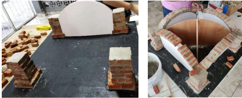
Figuras 33 y 34. Guías de triplay para el arranque de la cubierta junto con guías centrales y soporte de columna cuatropeada de tabique. Fuente: Morales (2021).
