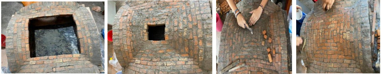
Figuras 26, 27, 28 y 29. Proceso de pegado de hiladas y terminación de la cubierta.
