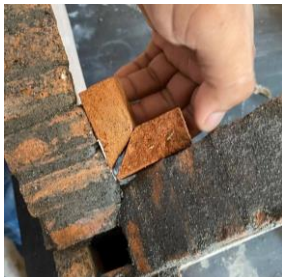
Figuras 23, 24 y 25. Hiladas de la cubierta de arista sin cimbra. Fuente: Morales (2021).
