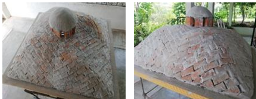
Figuras 50 y 51. Bóveda de Pañuelo Terminada. Fuente: Quintero & Morales (2021).
