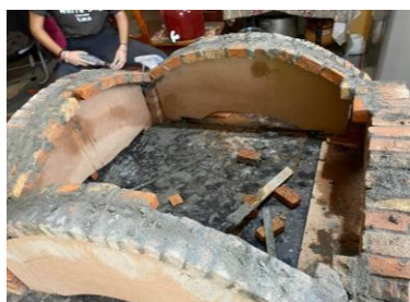
Figuras 23, 24 y 25. Hiladas de la cubierta de arista sin cimbra. Fuente: Morales (2021).
