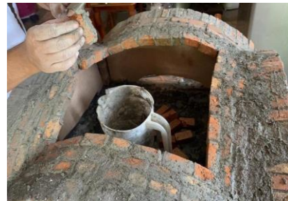
Figuras 23, 24 y 25. Hiladas de la cubierta de arista sin cimbra. Fuente: Morales (2021).
