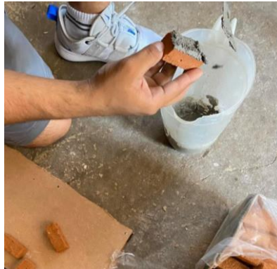
Figuras 16 y 17. La hidratación del tabique se realiza para que el pegado con mortero se adhiera más rápido. Fuente: Morales (2021).
