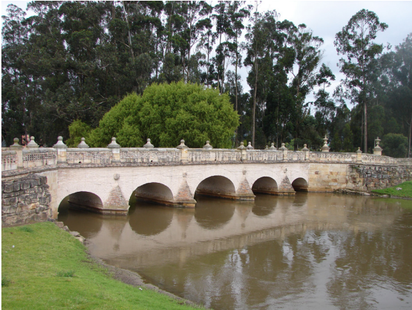
Figura 2. Puente del Común, Chía, Cundinamarca. Fuente: Kamilokardona, 2006. CC BY-SA 3.0
