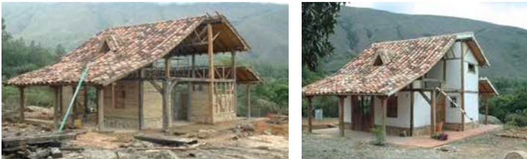
Figuras 16 y 17. Vivienda de bahareque con materiales reciclados en clima frío. Fuente: la autora.
