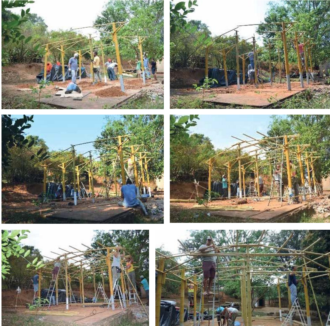
Figura 9. Mutirão para montagem da estrutura Y. Fonte: autores.
