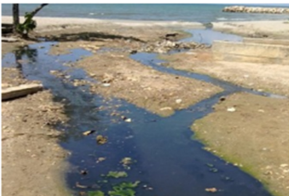
Figura 5. Aguas negras inundan viviendas y desembocan en el mar en una playa de Coveñas.
